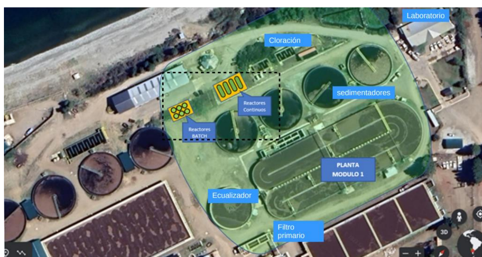
Imagen 4. Fotografía aérea PTE módulo 1 con Biorreactores prototipo. Fuente: Grupo IEDS CNEA y CEB
