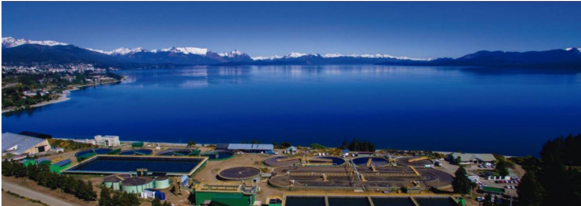
Vista aérea de la PTE Bariloche. Operador CEB. Fuente ENHOSA.
